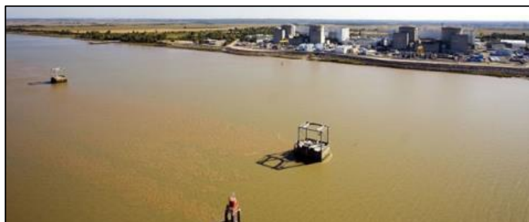
Figure 61. Vue depuis l'estuaire sur la CNPE du Blayais et prises d'eau amont et aval (source : energie.edf.com)
