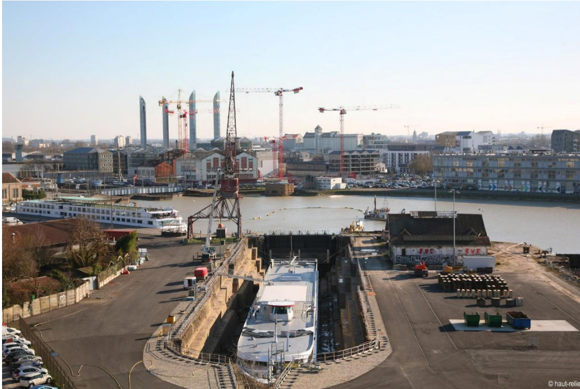
Forme de radoub # 1- Bordeaux
