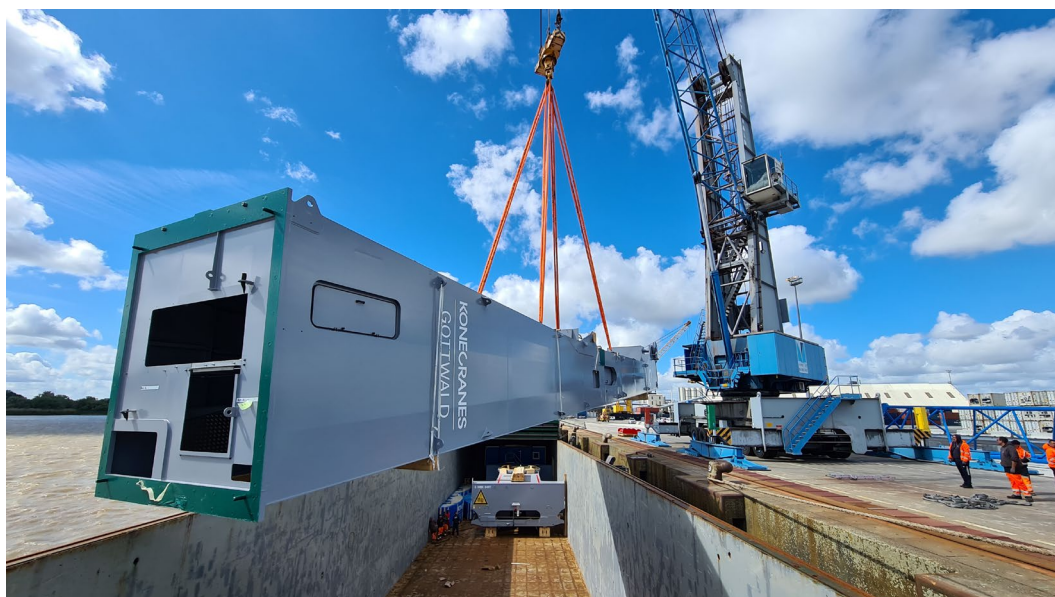
Déchargement de la nouvelle grue Gottwald – Bassens le 19/05/2021 Crédit GPMB
