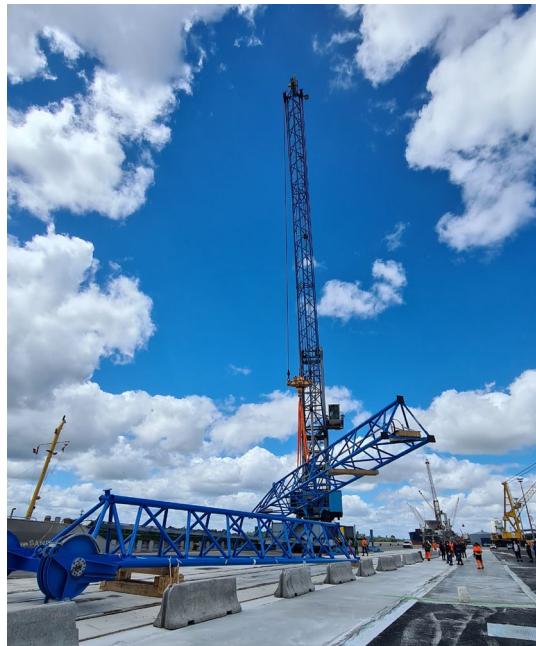
Déchargement de la nouvelle grue Gottwald – Bassens le 19/05/2021 Crédit GPMB
